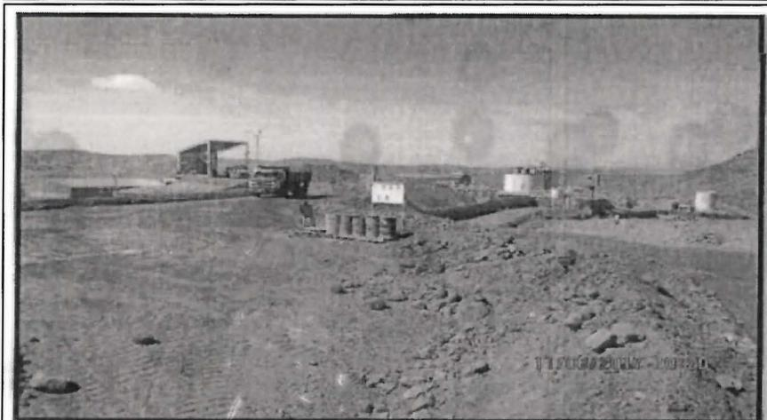
**Fotografía N° 183:** Vista de la parte superior de la Planta de Óxidos, que no habría implementado un sistema de derivación de las aguas de escorrentía superficial mediante un canal de coronación que bordea toda la planta de óxidos, de acuerdo a lo dispuesto en su Estudio de Impacto Ambiental Excepcional de la "Planta Complementaria para el Beneficio de Minerales Oxidados", aprobado por Resolución Directoral N° 236-2011-MEM/AAM del 01 de agosto de 2011.
