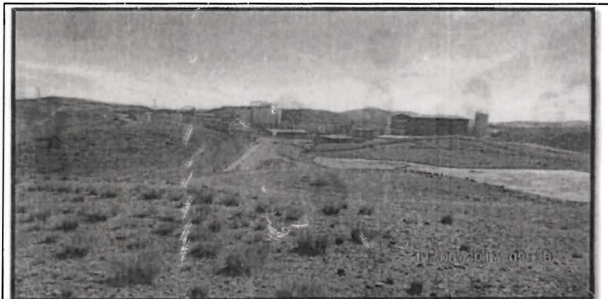
**Fotografía N° 182:** Vista panorámica de la Planta de Óxido, que no contaría con un sistema de derivación de las aguas de escorrentía superficial mediante un canal de coronación que bordea toda la planta de óxidos, de acuerdo a lo dispuesto en su Estudio de Impacto Ambiental Excepcional de la "Planta Complementaria para el Beneficio de Minerales Oxidados".
