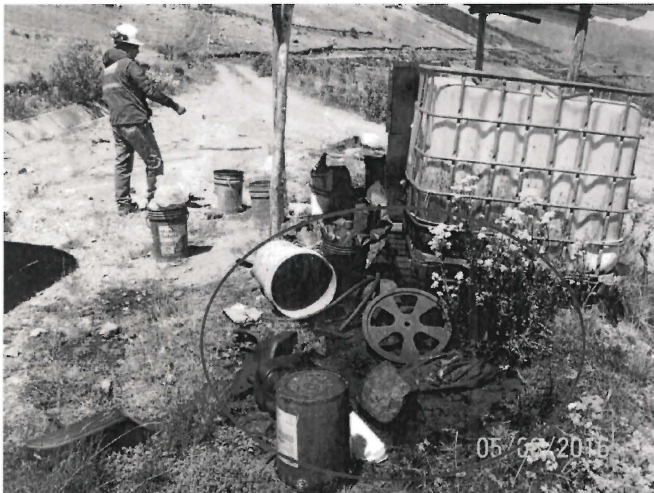
Fotografía N° 19. Vista del área de almacén de combustible donde se encontraba el grifo de combustible, el cual presentaba derrame de hidrocarburos sobre suelo natural. Ubicado en las coordenadas UTM WGS 84 Zona 18 E 169 915 N 9 106 388. (HALLAZGO N° 4)
