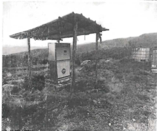
Fotografía N° 09: Otra vista del grifo de combustible, confirmandose la remedación del suelo, realizado en una anterior visita.
