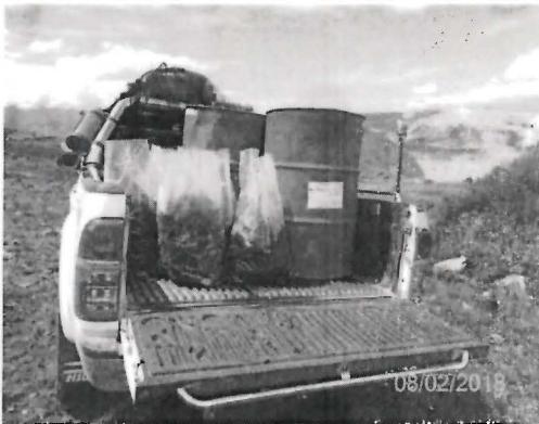
Fotografía N° 06: Las bolsas conteniendo suelo contaminado con hidrocarburo es llenado en bolsas de polietileno gruesas y los cilindros en mal estado, son recolectados, transportados y dispuesto finalmente en relleno sanitario autorizado. A cargo de la empresa prestadora de servicios de residuos sólidos (EPS-RS) SATISAC E.I.R.L. Se anexa la Constancia de Recolección y Transporte; la Constancia de Utilización de Relleno Sanitario y Manifiesto de Manejo de Residuos Sólidos Peligrosos.
