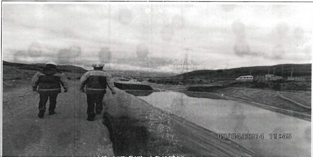
Fotografía N° 9: Canal de interceptación de agua superficial del lado oeste del tajo La Quinua 3 que deriva el agua de lluvia y subdrenaje del depósito de topsoil Ornamo hacia la quebrada Callejón que deriva el agua de lluvia y subdrenaje del depósito de topsoil Ornamo hacia la quebrada Callejón.
