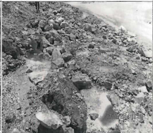
Fotografía N° 324: Agua ácida discurriendo hacia la cuneta de la vía de acceso ubicada al sur del depósito de desmonte Chiquiracha, lado sur.
