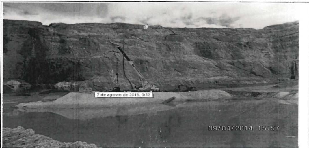
Fotografía N° 69: Mantenimiento de la bomba del Pozo TOPW-06, motivo por el cual no se realizaba el bombeo.
