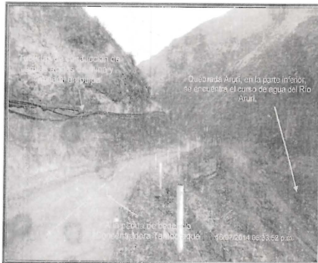
Fotografía N° 78: Conducción de agua de mina y Mineroducto. El agua de mina proveniente de la mina Coricancha y mineral en pulpa, proveniente de la planta de molienda, son transportados por medio de tuberías de polietileno a la planta de neutralización y a la planta de flotación, los cuales están instalados por el talud del cerro y no cuentan con un sistema de colección y contención para posibles casos de derrames y/o fugas.
