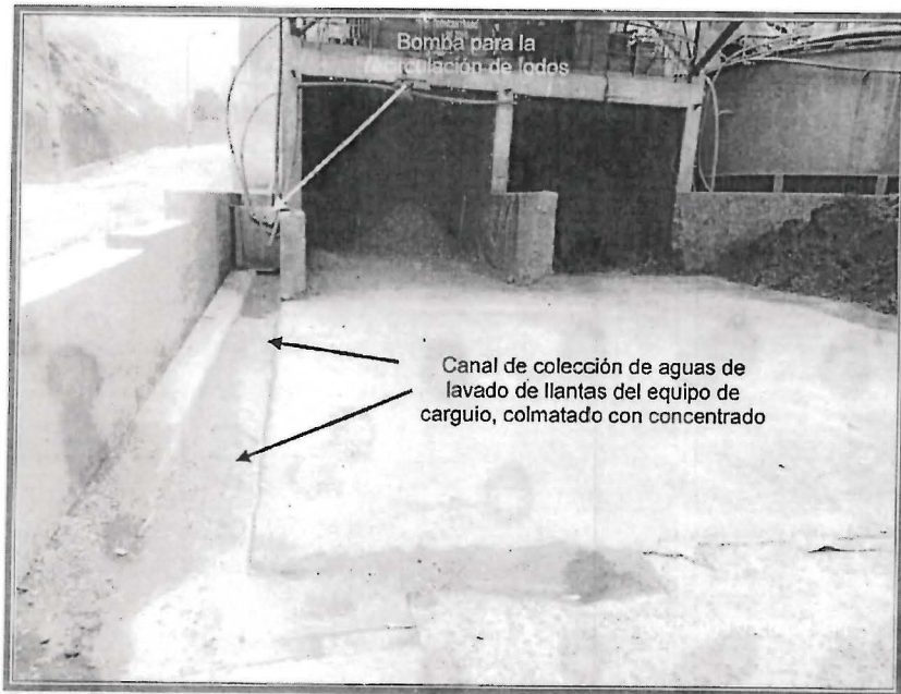
Fotografía N° 83: Depósito de concentrados de Plomo. En la plataforma de estacionamiento de camiones para el carguío de concentrados de Plomo, el canal de colección de las aguas de lavado de llantas del equipo carguío, se encuentra colmatado con concentrados.
