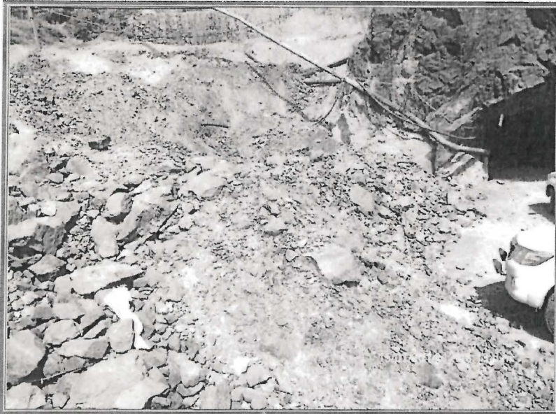
Fotografía N° 41: Botadero de desmonte Nivel 821, zona Constancia. Desmonte de mina dispuesto en una plataforma ubicado a un costado de la bocamina del Nivel 821, en las coordenadas UTM WGS 84, 358378E y 8695365N. No cuenta con estructuras hidráulicas para el manejo del agua de contacto y subdrenajes y, no existen medidas para prevenir la erosión eólica y arrastre de sedimentos.
