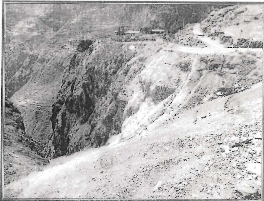
Fotografía N° 35: Botadero de desmonte Huamuyo Alto. El desmonte es dispuesto sobre el talud natural del lecho de la quebrada. No existe ninguna infraestructura para la contención de los desmontes almacenados. En el talud derecho obsérvese las huellas de la escorrentía de la parte alta. Aguas abajo se encuentra ubicado el río Aruri.
