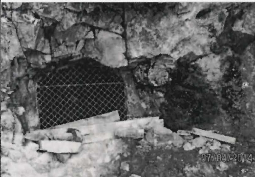
Fotografía N° 50. Chimenea 3 con coordenadas de ubicación UTM WGS 84 N:8379028; E:701349
