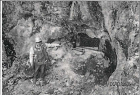
Fotografía N° 49. Chimenea N° 3 ubicada en el punto con coordenadas UTM WGS 84 N: 8379028 E: 701349 la cual se encuentra pendiente de cierre tal como se establece en los instrumentos ambientales.
