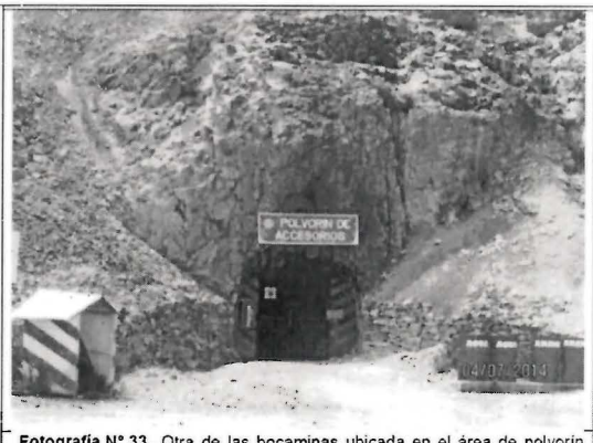
Fotografía N° 33. Otra de las bocaminas ubicada en el área de polvorin que actualmente viene utilizado para el almacenamiento de accesorios que se utiliza para voladura.
