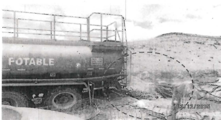
Fotografía N° 132: Se observó un camión cisterna descargando agua dentro de las pozas para almacenamiento de agua (Coordenadas UTM WGS84: E 359 670; N 8 430 396).
