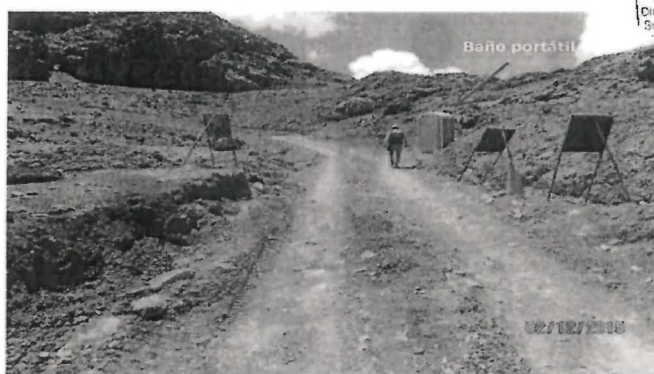
Fotografía N° 049: El acceso a la plataforma de perforación QUE56 se encontraba habilitado, asimismo no se observó cunetas de derivación, por otro lado se observó berna para el lado de la ladera (Coordenadas UTM WGS84: E 358 279; N 8 429 421).
