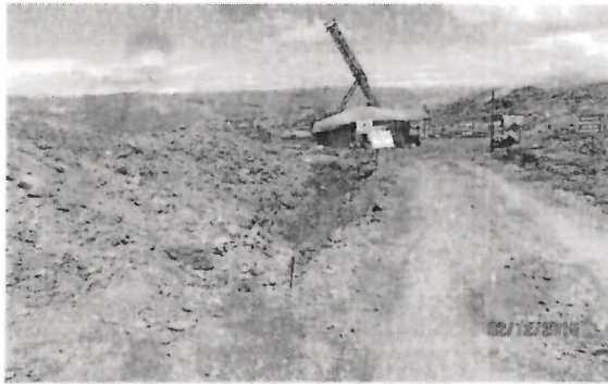
Fotografía N° 050: El acceso a la plataforma de perforación QUE56 se encontraba habilitado, asimismo no se observó cunetas de derivación, por otro lado se observó berna para el lado de la ladera (Coordenadas UTM WGS84: E 359 279; N 8 429 421).
