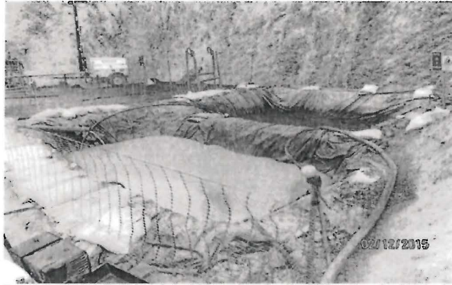
Fotografía N° 086: En el área de la plataforma de perforación IF030 se observó actividades de perforación de sondaje, asimismo, se verificó la existencia de 02 pozas delimitadas con malla anaranjada. (Coordenadas UTM WGS84: E 360 161; N 8 430 484).
