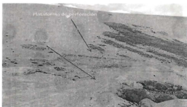
Fotografía N° 030: El acceso a la plataforma de perforación QUE26 se encontraba habilitado, asimismo no se observó cunetas de derivación, por otro lado se observó berna para el lado de la ladera (Coordenadas UTM WGS84: E 358 590; N 8 430 347).
