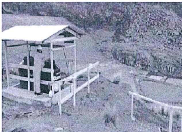
Foto 25: Vista del Sistema de dosificación de Reactivos de la Relavera Oasis
