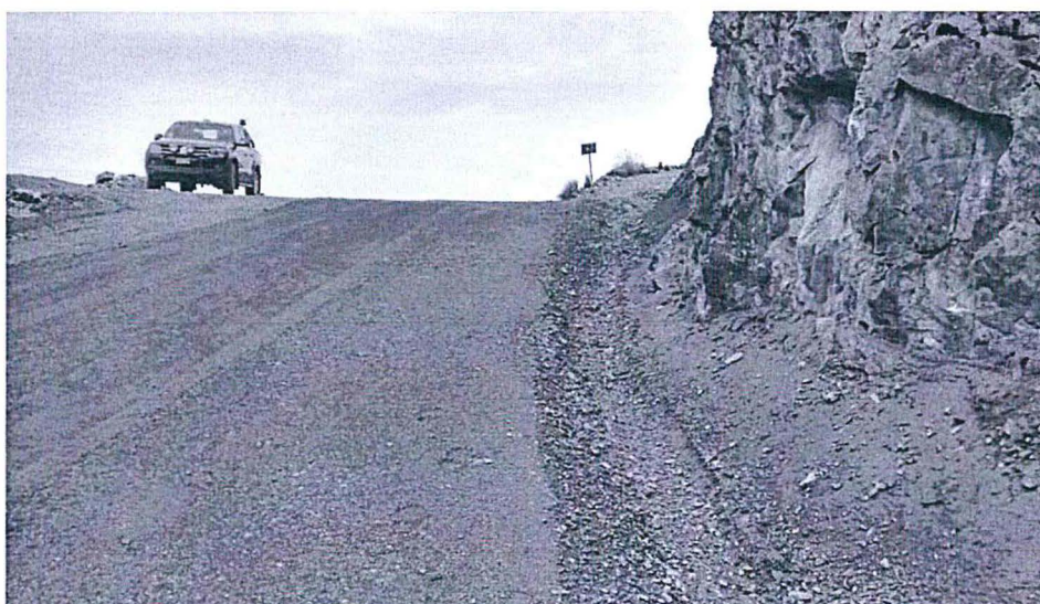
Foto 5: Vista Parcial del Canal de la Desmontera 1 Orientación Sur a Norte
