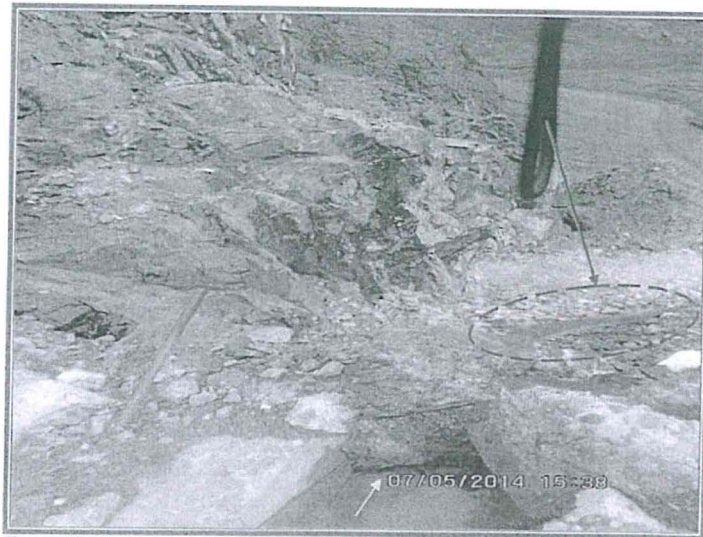
Fotografía N° 10: Descarga de las pozas de sedimentación de la bocamina Sabrina. Nótase una tubería de HDPE que sale de la poza y hace que el agua caiga sobre uno de los costados del cerro donde se encuentra ubicada la bocamina.
