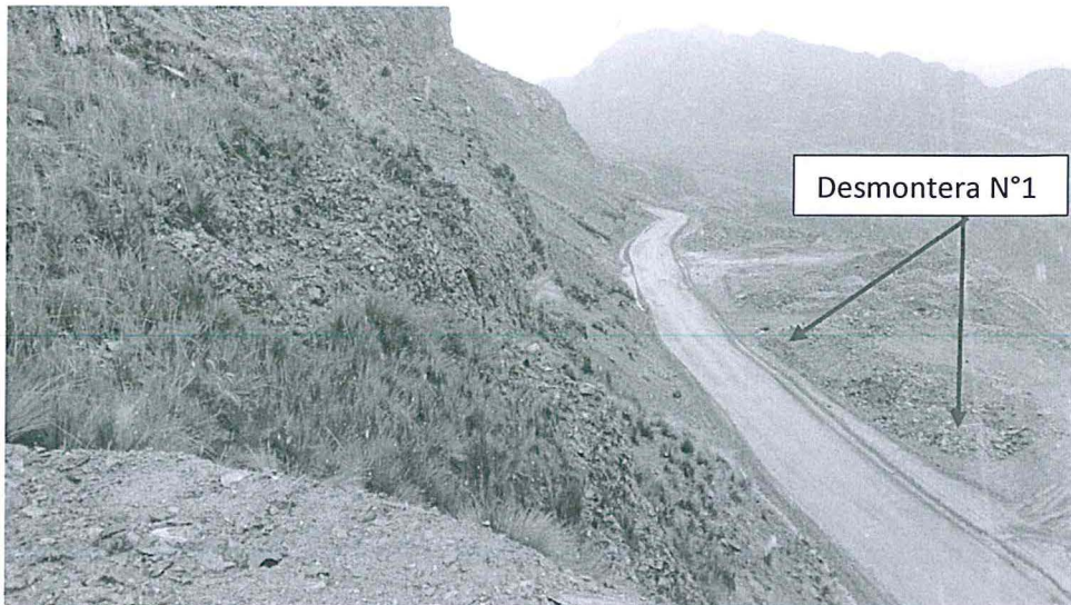
Foto 1: Vista General de la Desmontera 1 y Canal de Captación de agua de Escorrentía
