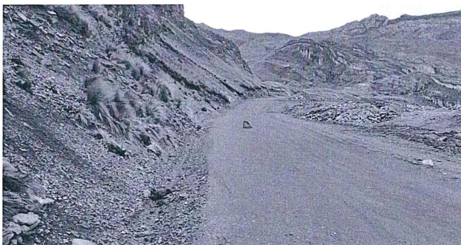
Foto 4: Vista Parcial del Canal de la Desmontera 1 Orientación Norte a Sur
