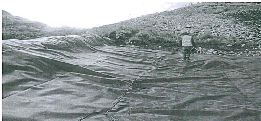
Foto 24: Vista de Trabajos de Reparación de Geomembrana en Relavera Oasis
