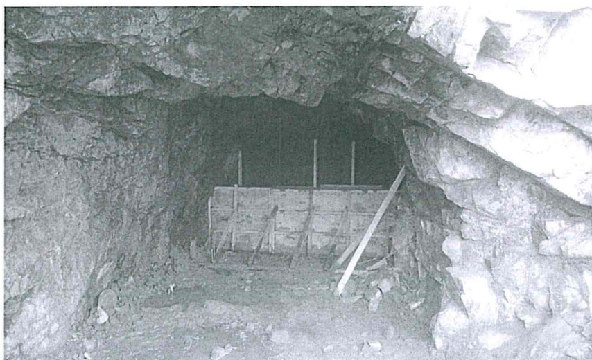
Foto 22: Muro de Derivación de Efluente de Bocamina Nv. 4,700
