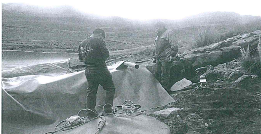
Foto 23: Vista de Trabajos de Reparación de Geomembrana en Relavera Oasis
