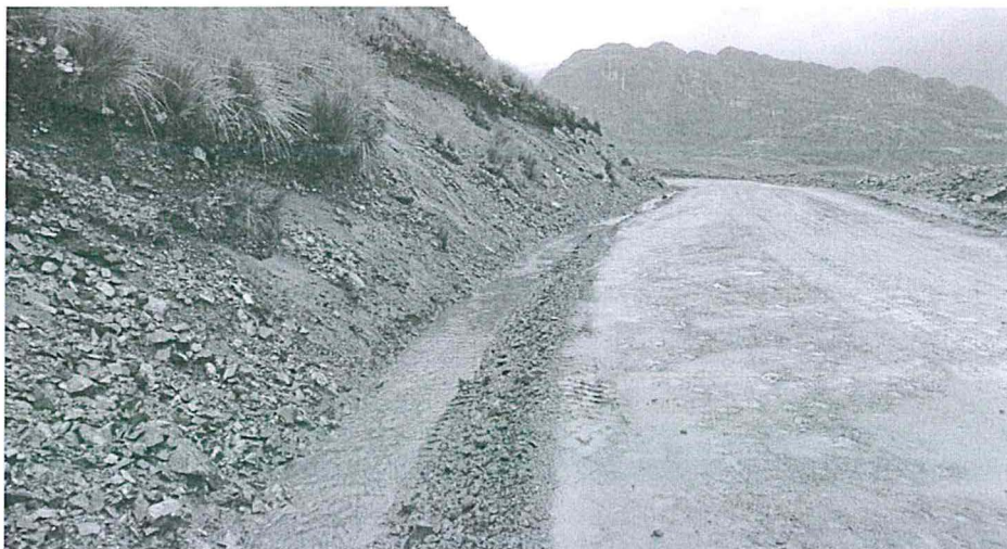
Foto 3: Vista del Canal de Captación de Agua de Escorrentía de la Desmontera 1 en funcionamiento
