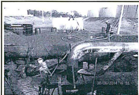
Foto N° 3. Vista del bombeo del petróleo crudo que se drenaba de la brida ciega hacia un tanque ubicada en un lugar adyacente de la fosa abierta para reparar la falla
