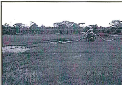
Foto N° 12. El agua filtrada en la fosa con trazas de hidrocarburo fueron bombeadas a un área abierta cubierta con vegetación herbácea, impactada en 1809,6 m² dentro de la zona industrial. En la vista puede observarse el agua con indidencias y trazas de hidrocarburo.
