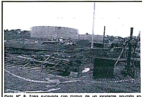
Foto N° 9. Fosa excavada con motivo de un incidente ocurrido en diciembre de 2011. Al fondo puede observarse la retroexcavadora con la que se abrió la fosa y los operarios para atender el incidente ocurrido el 30.08.2014. Asimismo, se distingue la manguera que desfogó el agua proveniente de la fosa del incidente.
