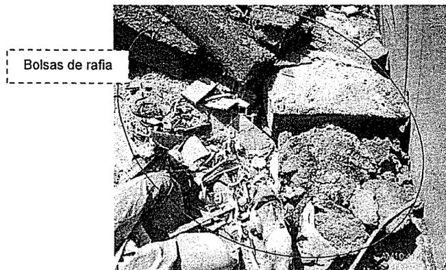
Fotografía N° 3: Vista fotográfica donde se acumulan residuos sólidos peligrosos (escoria de plomo), sobre piso de concreto a la intemperie sin delimitar el área.
