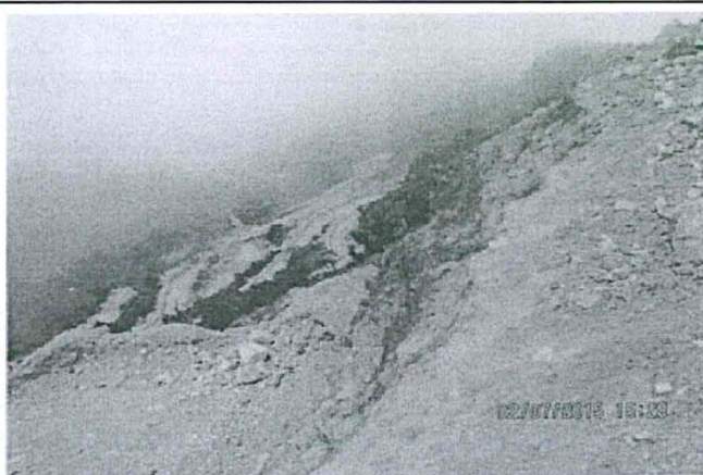
Fotografía N°8. El tajo Pampa Verde no cuenta con canal de captación y derivación de aguas de escorrentía en la parte Nor Este en las coordenadas UTM WGS84 N 9245840, E 730596 y N 9245871, E 730504, asimismo se observó material de desbroce sobre la vegetación en esa zona. Hallazgo N° 1.
