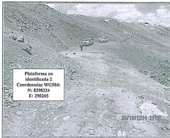
Fotografía N° 43: Hallazgo N° 1, Supervisión Regular octubre 2014, Vista de la plataforma no identificada 2 y su acceso, se encuentran fuera de la concesión del proyecto.
