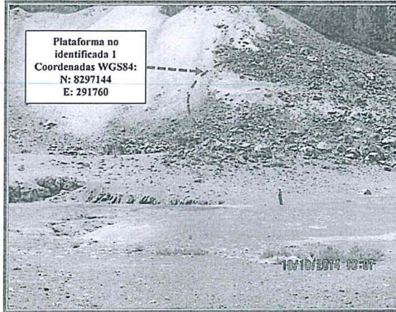
Fotografía N° 38: Hallazgo N° 3 (gabinete), Supervisión Regular octubre 2014, Se observó que la plataforma ubicada en las coordenadas UTM WGS 84 E: 291760, N: 8297144 (no identificada 1), fue ejecutada a una distancia mayor a los 50 metros lineales de la ubicación señalada en la DIA Callatía.
