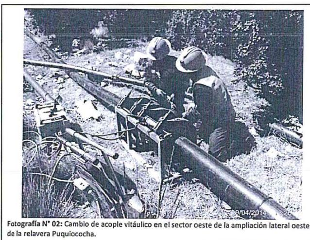
Fotografía N° 02: Cambio de acople vitáulico en el sector oeste de la ampliación lateral oeste de la relavera Puquiocochoa.
