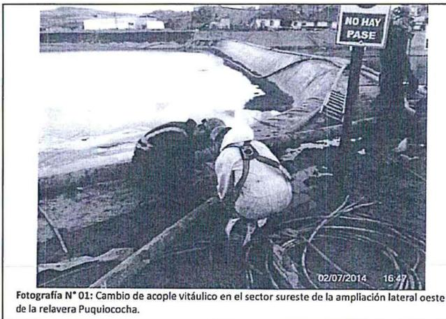
Fotografía N° 01: Cambio de acople vitáulico en el sector sureste de la ampliación lateral oeste de la relavera Puquiocochoa.
