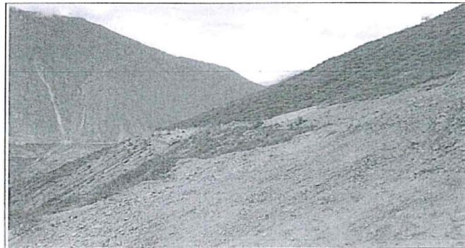
Acceso- Tramo C – Después (este sector no se revegetó a pedido del Sr. Julián Pumariera) Coordenadas al inicio del acceso Este 178 594 Norte 9 030 219
