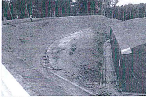
FOTO N° 18. Talud al helipuerto protegido con biomantas
