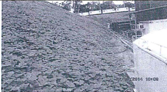
FOTO N° 46. Talud con vegetación.
