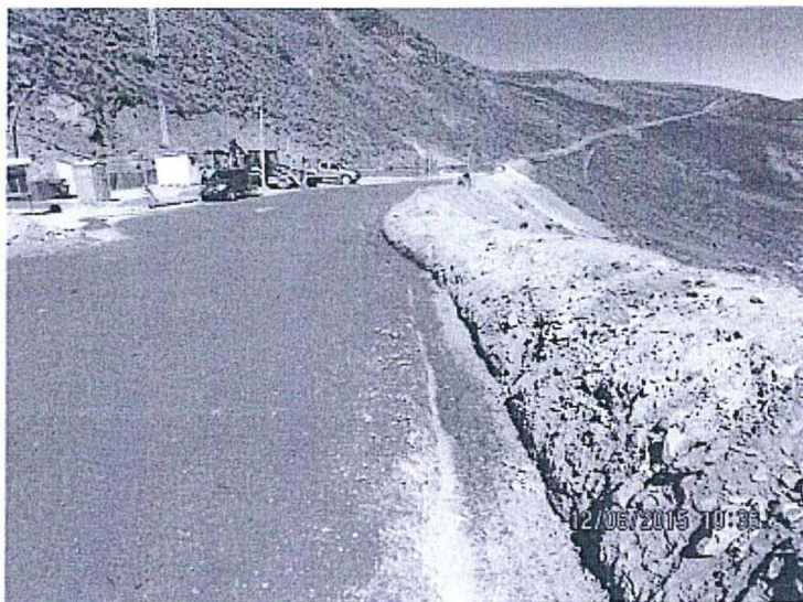
Fotografía 4 Cuneta en el Nivel 4300 de superficie, margen derecha del acceso, para manejo de agua de escorrentía. Coordenadas UTM WGS84: E 687396, N 8346672.
