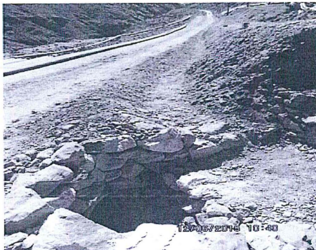
Fotografía 7 Alcantarilla en el Nivel 4300 de superficie, margen izquierda del acceso, para manejo de agua de escorrentía. Coordenadas UTM WGS84: E 687306, N 8346581.
