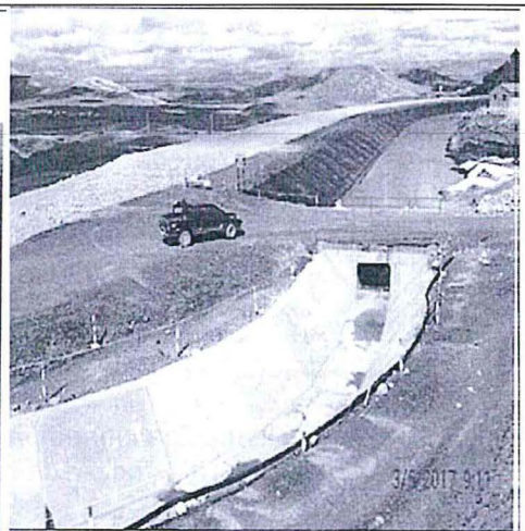
Fotografía N° 3.- El depósito de relaves Ocroyoc cuenta con un canal-vertedero de concreto armado. UTM Datum WGS 84: 8817217 N y 358833 E
