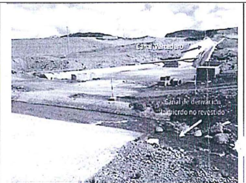
Fotografía N° 5.- El depósito de relaves Ocroyoc cuenta con un canal – vertedero de concreto armado, el que se conecta con el canal de derivación izquierdo no revestido de la relavera, según las obras de ingeniería diseñadas por el consultor Golder. UTM Datum WGS 84: 8817098 N y 358 922 E
