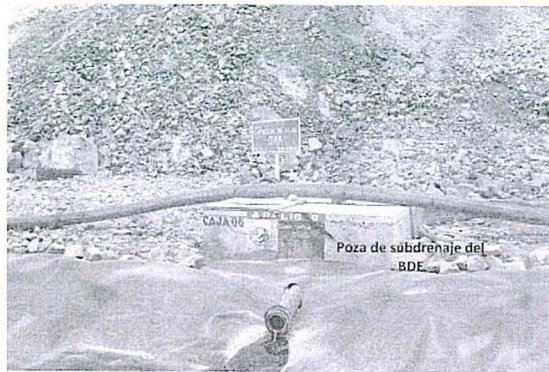
Fotografía N° 15: Vista de la poza de subdrenaje "Poza DAR", del Botadero de Desmonte Este (BDE), ubicado en las coordenadas UTM Datum WGS 84: 9121304 N y 804464 E.
