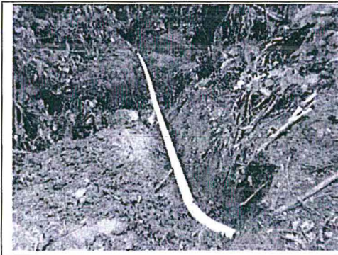
Fotografías N° 1 y 2: Reemplazo de la tubería y conexión al área de infiltración
