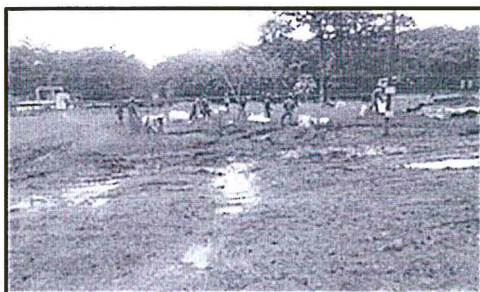
Fotografía N° 4: Zona impactada en el área de la batería.
