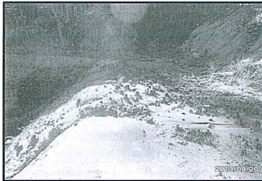
Fotografía 7: Área sin Revegetación Banco del talud al norte de la poza de quema de la Plataforma del pozo Picha 2X sin cobertura vegetal y expuesto a erosión.
