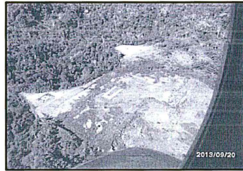
Fotografía 6: Vista aérea de la plataforma del Pozo Picha 2X.
