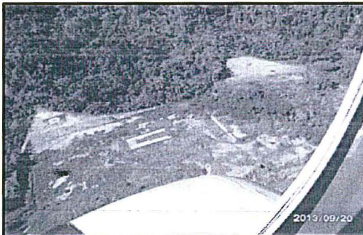
Fotografía 5: Vista aérea de la plataforma del Pozo Picha 2X.
