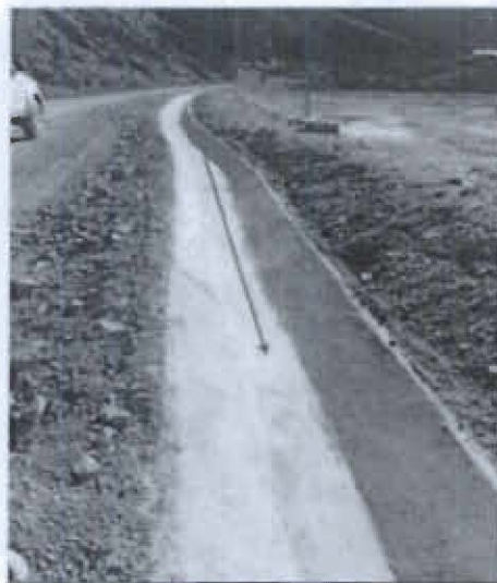
Foto 5: Canal de coronación del nivel P Sur (N°1)
