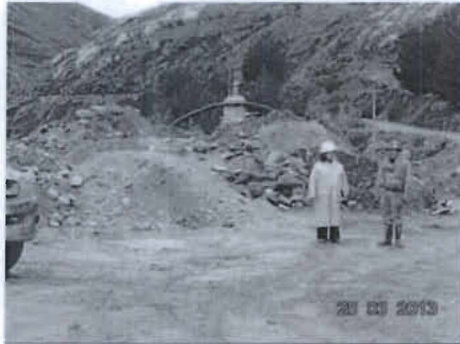
Foto 4: Botadero de desmonte del nivel P Sur (N°2) luego de retirar el desmonte de la parte superior, perfilado y con canal de colección de drenajes
