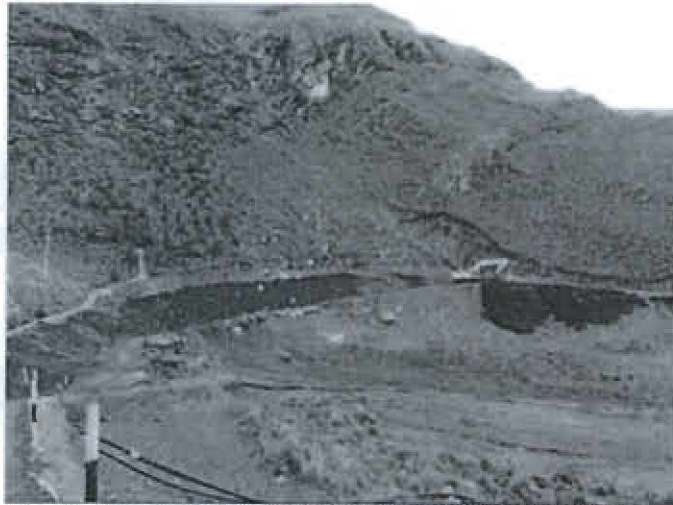
Foto 22: Botadero de desmonte GX-1600 en proceso de cobertura con top soil.
