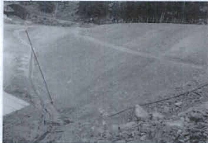
Foto 5: Canal de coronación del nivel P Sur (N°1)
