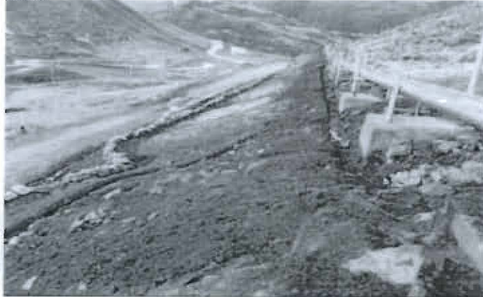
Foto 18: Proceso de reposición de suelo impactado con top soil
