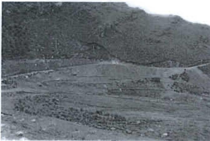
Foto 23: Botadero de desmonte GX-1600 en proceso de revegetación.
