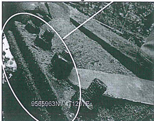
Pernos de sujeción de la grapa aflojados
