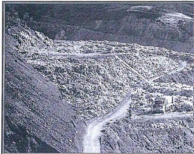
Fotografía N° 13: Hallazgo N° 1 Botadero Rumiallana. Vista de la plataforma del Botadero Rumiallana donde se realiza la disposición de residuos sólidos domésticos, donde un camión realiza la descarga de los residuos sólidos domésticos del día, proveniente de las instalaciones del titular minero.
