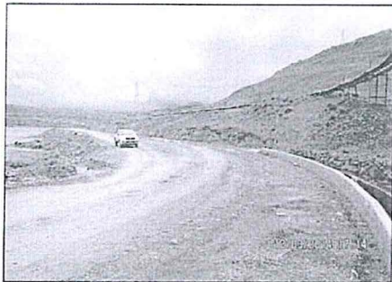
Fotografía N° 4. Se observa que desde la Planta de neutralización hasta el depósito de relaves Ocroyoc, la línea de conducción de relaves no cuenta con un sistema de contingencia para posibles casos de derrame y/o fuga de relaves. Al costado se encuentra ubicado el canal de concreto que canaliza las aguas del río Ragra.
