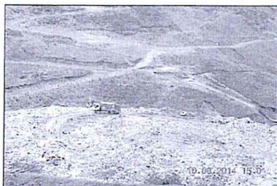
Fotografía N° 1. Vista del ingreso de un camión recolector de los residuos sólidos domésticos al depósito del desmonte Rumiallana.
