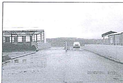
Fotografía N° 9. Vista del área de lavado de llantas de los camiones y equipos utilizados en el carguío.
