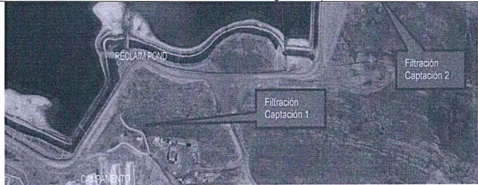
Grafico 1: Ubicación de las filtraciones en la Poza de Agua Recuperada
