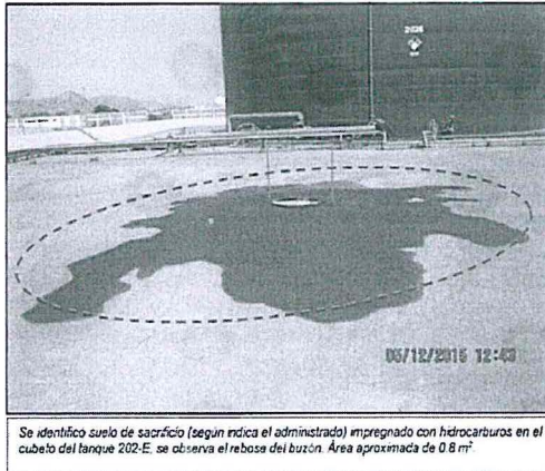
Registro Fotográfico N° 66: Cubeto del tanque 202-E
