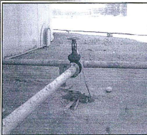
Tanque 1-A Fotografía 11: Antes
