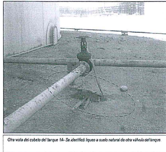
Registro Fotográfico N° 71: Cubeta del tanque 1-A
