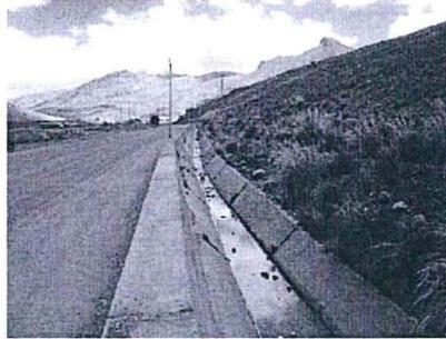
**Foto N° 4: Descarga de aguas ácidas de las relaveras N° 2 y 3 al canal**
