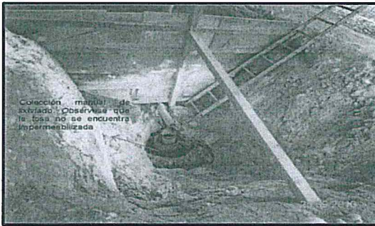
Fotografía N° 3: Fosa de Residuos. Obsérvese, que la fosa no se encuentra impermeabilizada y asimismo se constató la colección manual de lixiviados. Cabe precisar, que la colección de lixiviado sería optima si las celdas que conforman la fosa estarían impermeabilizadas.
