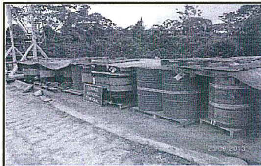
Fotografía N° 7: Vista del área destinada para almacenar productos químicos, lubricantes y diésel en CORPESA, observándose que los productos están expuestos a las lluvias y el área sólo cuenta con un sistema de contención (pit o muro de contención).
