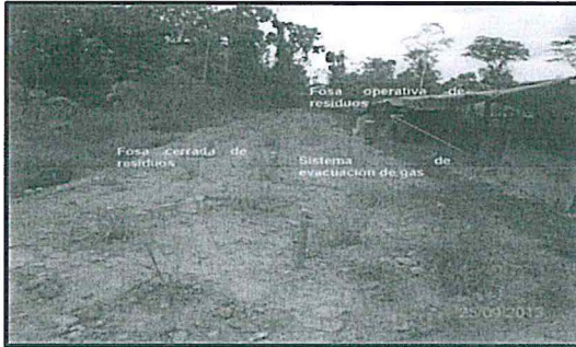
Fotografía N° 1: Fosa de Residuos. Obsérvese, que la empresa ha cerrado una fosa de residuos y asimismo viene operando una fosa.
