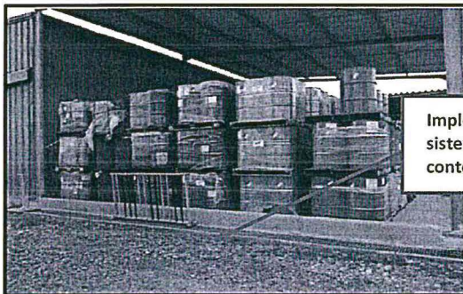
Fotografía 1: Implementación de dique de contención de concreto en el Almacén de Lubricantes situado al Norte del Galpón de Drilling.
