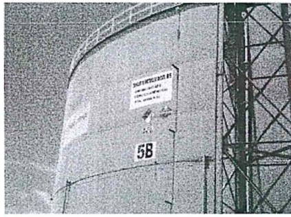
Fotografía N°7: Vista general del tanque N°5B
