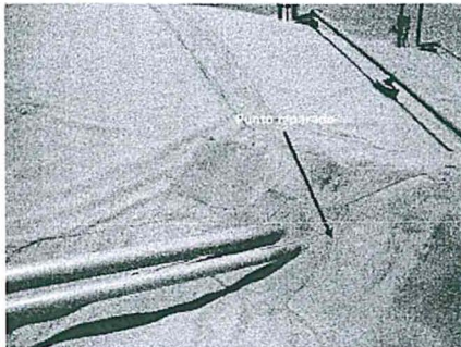
Fotografía N°9: Puntos reparados de geomembrana
