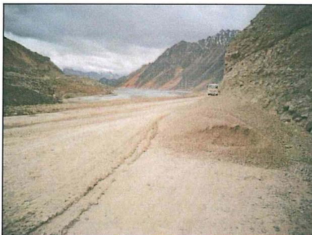
Se aprecia material de cantera depositado a un lado de la carretera para ser empleado en el mantenimiento de dicho acceso.
