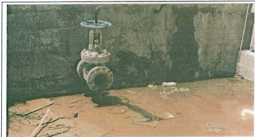
Fotografía N° 78 **Hallazgo N° 4:** Otra vista de salida de agua de la válvula a la base de contacto de la relavera. Ubicado en las coordenadas N8710315, E367670 – WGS84.
