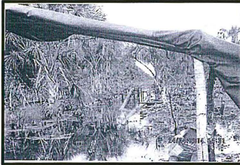
Fotografía: Se evidencia que no existe avance de los trabajos de remediación desde la última supervisión realizada el 20 de diciembre del 2013.
