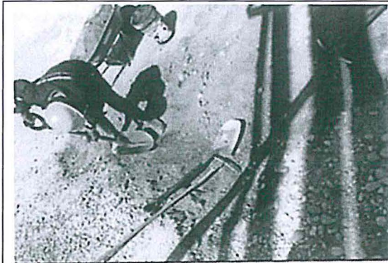
Foto N° 35: Área de procesos de la Refinería Talara. Levantando los suelos impactados con hidrocarburos (detectados de forma oronolítica)
