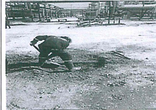
Foto N° 34: Área de procesos de la Refinería Talara. 10 m 2 de suelos contaminados con hidrocarburos (detectados de forma oronolítica)
