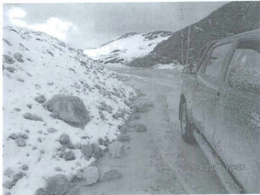
Fotografía N° 140 Acceso del depósito de diamantes Caste. La curista requiere mantenimiento
