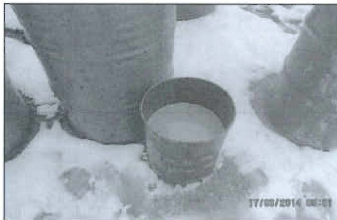
Fotografía N° 379: Aceites residuales en un contenedor abierto en la plataforma de armado.
