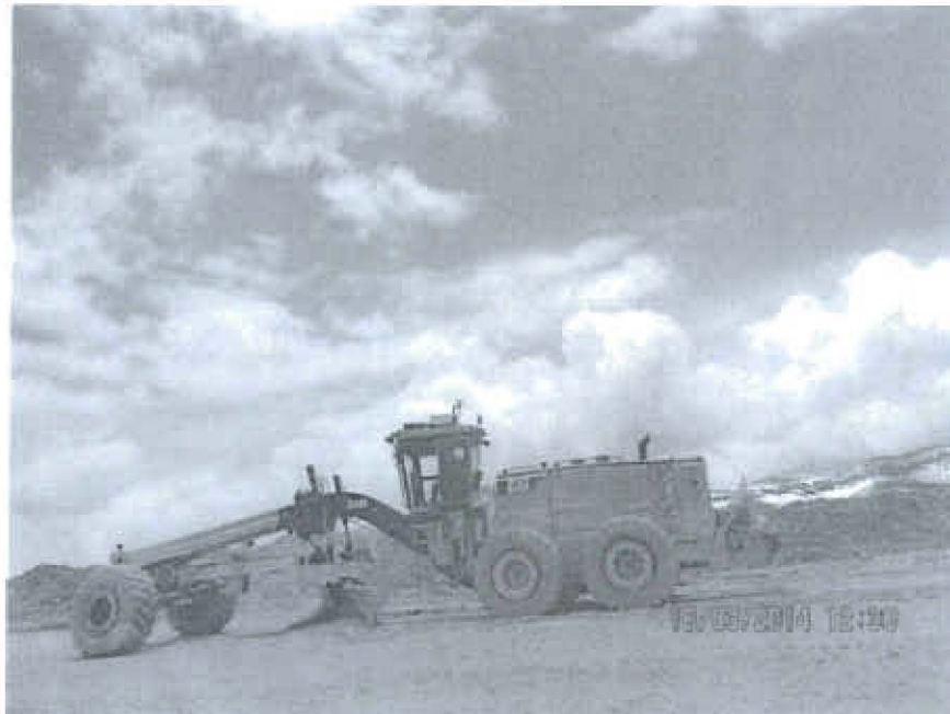
Fotografía N° 3. Mantenimiento de los accesos del tajo
