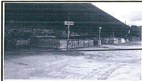
Se observa el almacén de sustancias químicas y lubricantes sin impermeabilizar ni sistema de doble contención
