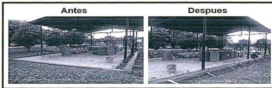
Vista del almacén de sustancias químicas de la Central Eléctrica en la cual se aprecia la implementación de áreas impermeabilizadas y sistema de doble contención.
