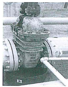
Rack de tubería frente al TK-67
