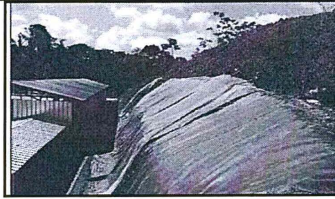
Recubrimiento con geomembrana (octubre del 2016)
