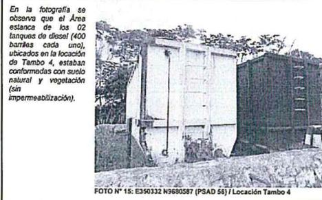
En la fotografía se observa que el Área estanca de los 02 tanques de diésel (400 barriles cada uno), ubicados en la locación de Tambo 4, estaban conformadas con suelo natural y vegetación (sin impermeabilización).
