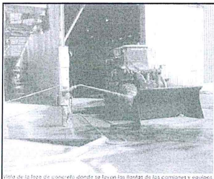
Vista de la losa de concreto donde se lavan las llantas de los camiones y equipos.
