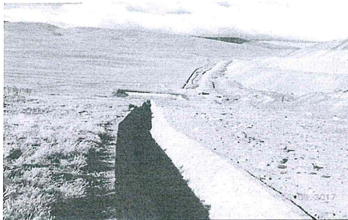
Foto N°1: Vista del canal de derivación y reservorio de captación de aguas de escorrentía del depósito de desmonte Condorcayán
