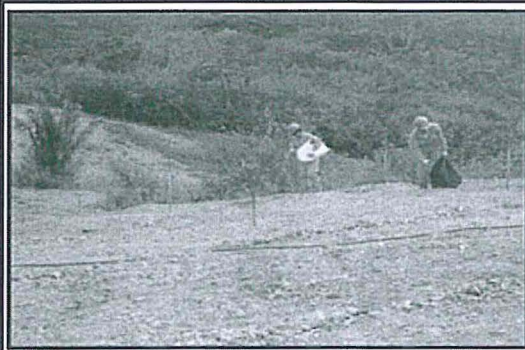
Foto 5. Proceso de remediación de suelos en las canchas de volatilización. Fecha: 06/05/2016.
