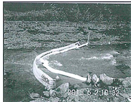
Foto N° 22: Quebrada Kintipiri Zona de control 1B A de acuerdo al Plan de Contingencias. Detalle de la instalación de barrera de contención y chorizo oleofílica con el objeto de recuperar el LGN sobre el cuerpo de agua. Coordenada UTM sistema WGS84: 0658512E, 8570915N.
