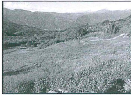
Foto 7. Proceso de reconformación del área de trabajo. Fecha: 25/06/2016.
