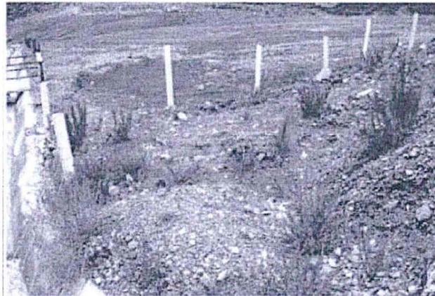
300. De la fotografía anterior, se observa que en efecto, el titular minero retiró el lodo acumulado en la poza, la geomembrana, las tuberías y habría derrumbado el muro de concreto donde éstas se habían instalado; además, se advierte que en el sector donde se encontraba la poza existen arbustos silvestres en crecimiento.
