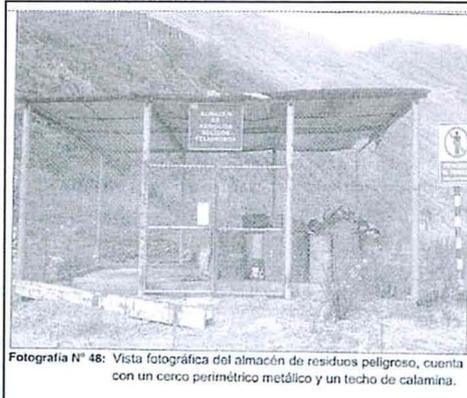
Fotografía N° 48: Vista fotográfica del almacén de residuos peligrosos, cuenta con un cerco perimétrico metálico y un techo de calamina.
