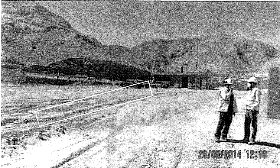
Fotografía 4: Se observa el proyecto de la "Línea de Transmisión" que se encuentra en la fase de construcción.
