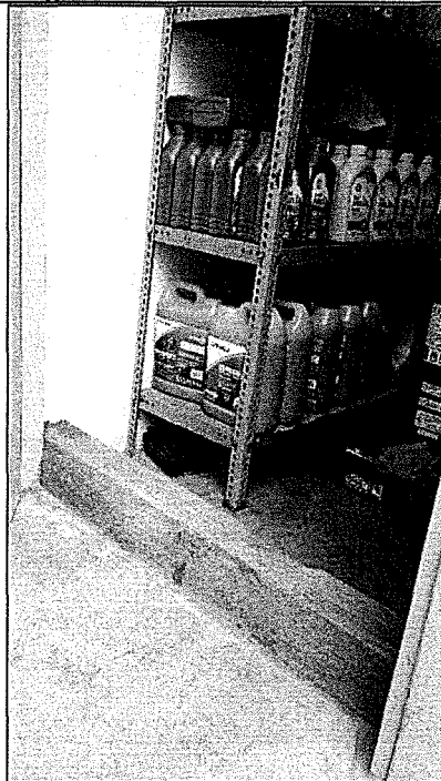
Imagen N° 5: Sistema de contención
