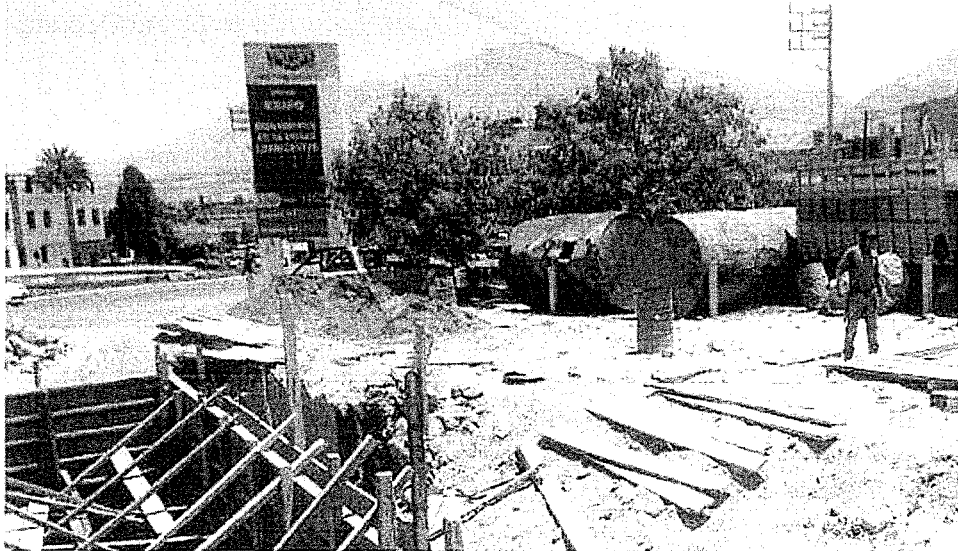
Fotografía N° 23.- En la imagen se advierte trabajos para recubrir con concreto la fosa donde se instalará nuevos tanques, así como, se visualiza al costado derecho dos (2) de los tanques antiguos retirados en la Estación de Servicios de la empresa ESTACION DE SERVICIOS MOQUEGUA S.R.L.
