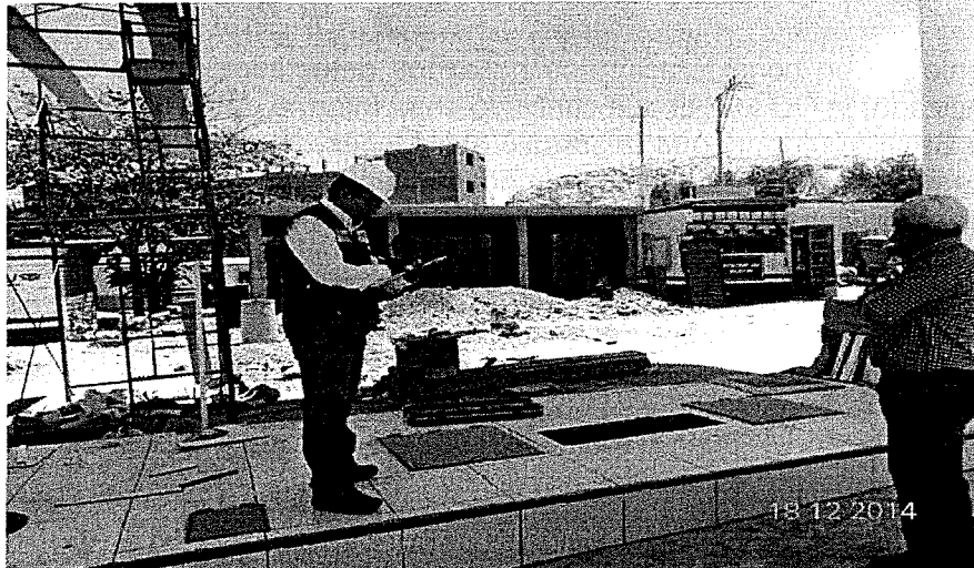
Fotografía N° 02.- Vista Isla N° 2 de la Modificación y Ampliación de Estación de Servicios Moquegua para uso Automotor de Dora Alicia Mory Hinojosa Coordenadas UTM 0295666 y 809854N.
