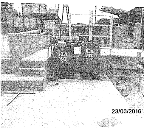
Fotografía N° 4: Se observa los contenedores acopiados sobre piso de concreto.
