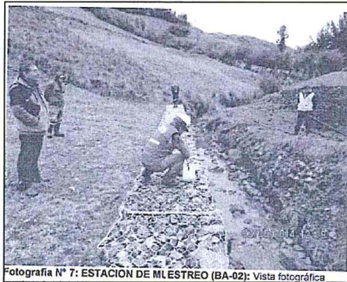
Fotografía N° 7: ESTACION DE MLESTREO (BA-02): Vista fotográfica
