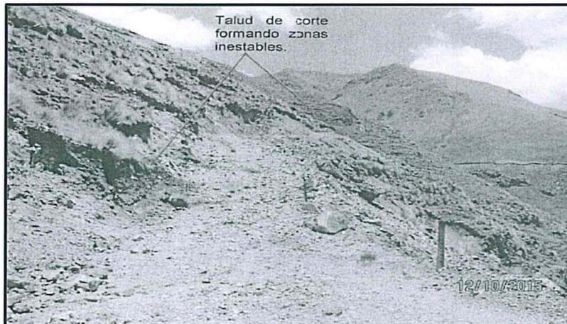
Fotografía N° 16: Otra vista del acceso existente en el proyecto de exploración Pachaconas la cual se encuentra abierta y con el talud erosionado.
