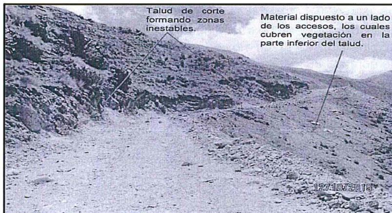
**Fotografía N° 14:** Vista del acceso existente en el proyecto de exploración Pachaconas. Se encuentra abierto, presentando talud de corte y con el material de desbroce depositado a un lado de los mismos.
