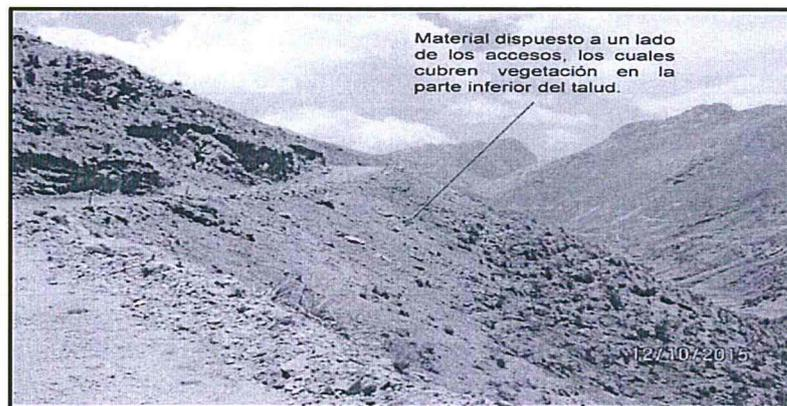
**Fotografía N° 13:** Vista del acceso existente en el proyecto de exploración minera Pachaconas, la cual se encuentra abierta. El material de corte se encuentra dispuesto en el talud inferior cubriendo la vegetación aledaña.
