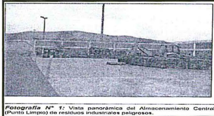
Fotografía N° 1: Vista panorámica del Almacenamiento Central (Punto Limpio) de residuos industriales peligrosos.
