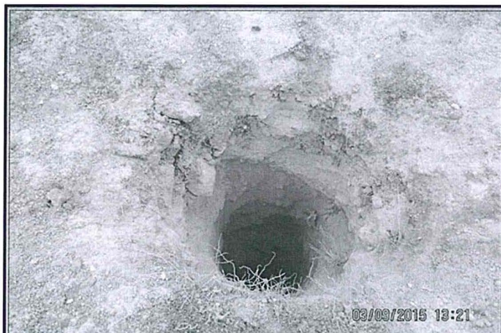
Fotografía N° 2.- Otra vista fotográfica del área de la plataforma ejecutada no contenida en el EIASd Ayahuanca. Se observa perforación en el suelo.
