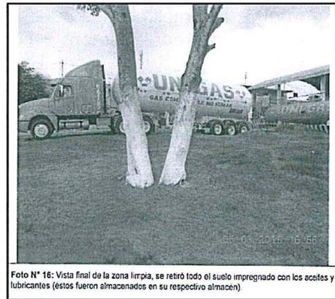
Foto N° 16: Vista final de la zona limpia, se retró todo el suelo impregnado con los aceites y lubricantes (éstos fueron almacenados en su respectivo almacén).
