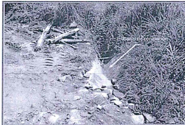
Fotografía N° 51: Depósito de relaves La Esperanza. Vista del canal de coronación del lado este del depósito de relaves, que deriva la escorrentía proveniente del talud aguas arriba del depósito hacia el río Yanayacu. Hallazgo N° 3.
