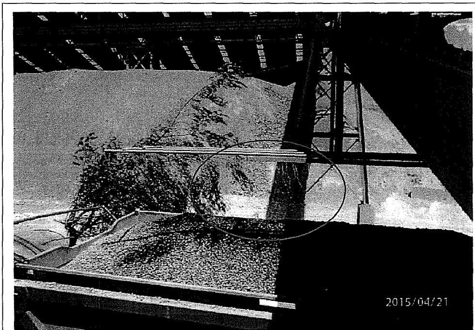
Fotografía N° 13: Vista de humedecimiento de la caliza mediante aspersores, previo a su descarga en las tolvas.
